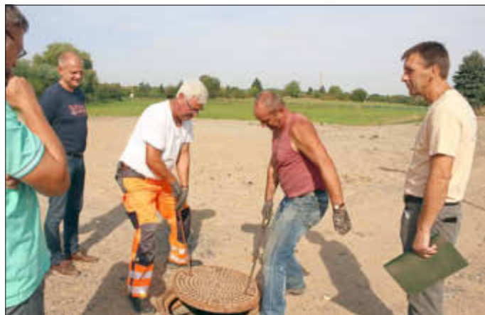
Genauere Kontrollen bei der Bauabnahme
