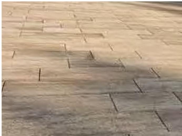
Hauptachse: Betonpflaster Großformat
